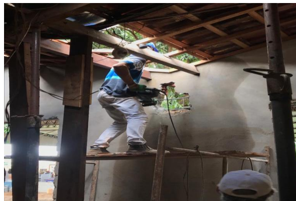
Figura 8. Imagens que denotam irregularidades, como falta de proteção contra queda (a e b). Fonte: Autores (2019).
