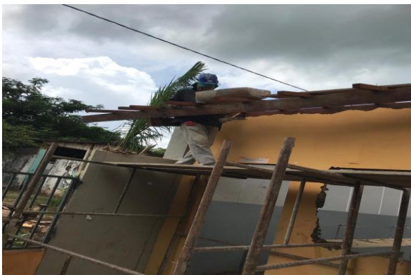
Figura 8. Imagens que denotam irregularidades, como falta de proteção contra queda (a e b). Fonte: Autores (2019).
